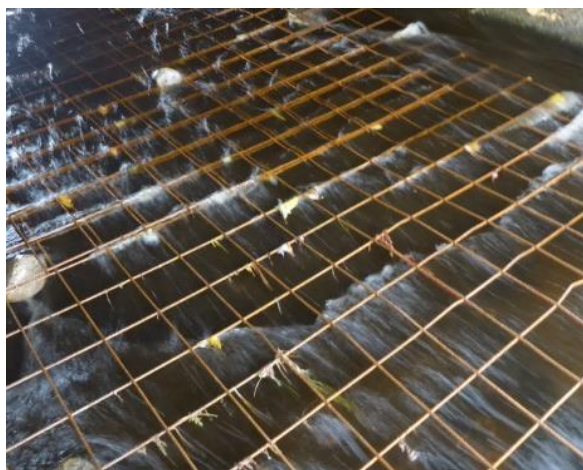
Exempel på hur en vägtrummans botten armerats samt utkörning av material i en rörbro med minidumper. Foto: Anders Bruks
