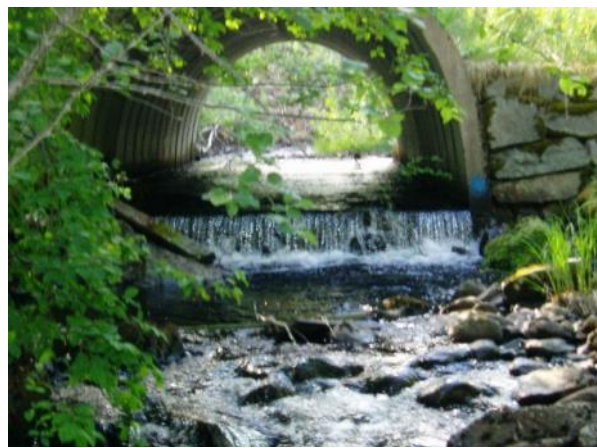
Vägtrumman före åtgärd 2008 (högra bilden) samt 2016 efter åtgärd (vänstra bilden). Ytterligare åtgärder avses genomföras för att eliminera det ca 30 cm höga fall som återstår.
