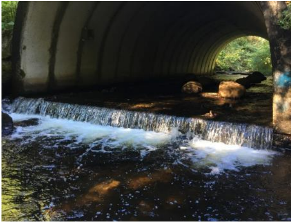
Vägtrumman före åtgärd 2008 (högra bilden) samt 2016 efter åtgärd (vänstra bilden). Ytterligare åtgärder avses genomföras för att eliminera det ca 30 cm höga fall som återstår.
