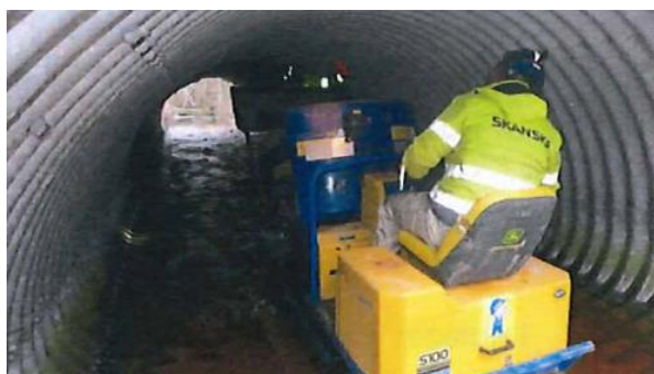
Exempel på hur en vägtrummans botten armerats samt utkörning av material i en rörbro med minidumper. Foto: Anders Bruks
