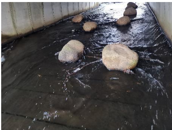
Bilden till vänster visar de sten/block som är utplacerade inne i vägtrumman med. Som grundast vid fältbesöket var den 5 cm. Botten består av "betongslippers" vilket gör den slät och ensidig. Bilden till höger visar strax uppströms inloppet till vägtrumman.
